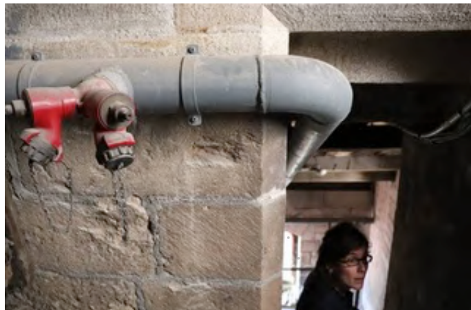
COLONNE SECHE EXISTANTE PRISES HAUTES COMBLES NEF
