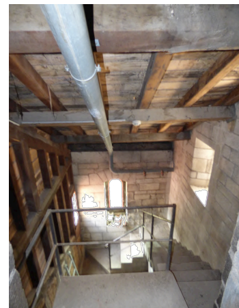
COLONNE SECHE EXISTANTE PRISES HAUTES COMBLES BAS-CÔTÉ SUD
