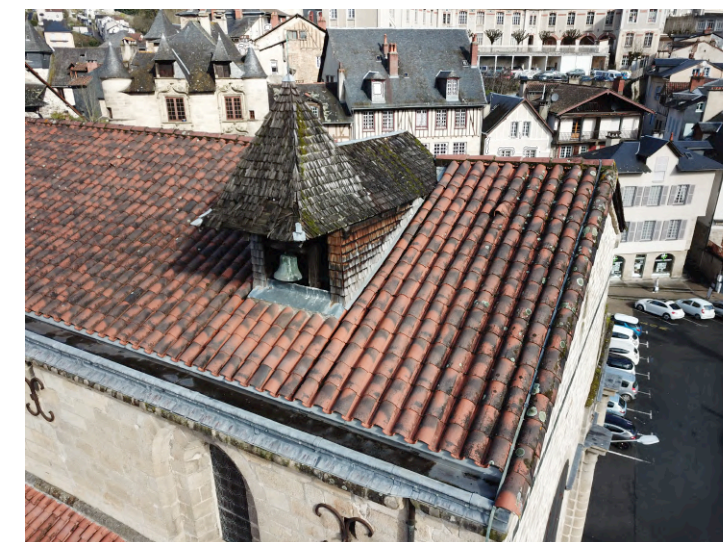
ACCES AUX COMBLES DE LA NEF PAR LA LUCARNE Fermeture provisoire de la lucarne par porte isoplane
